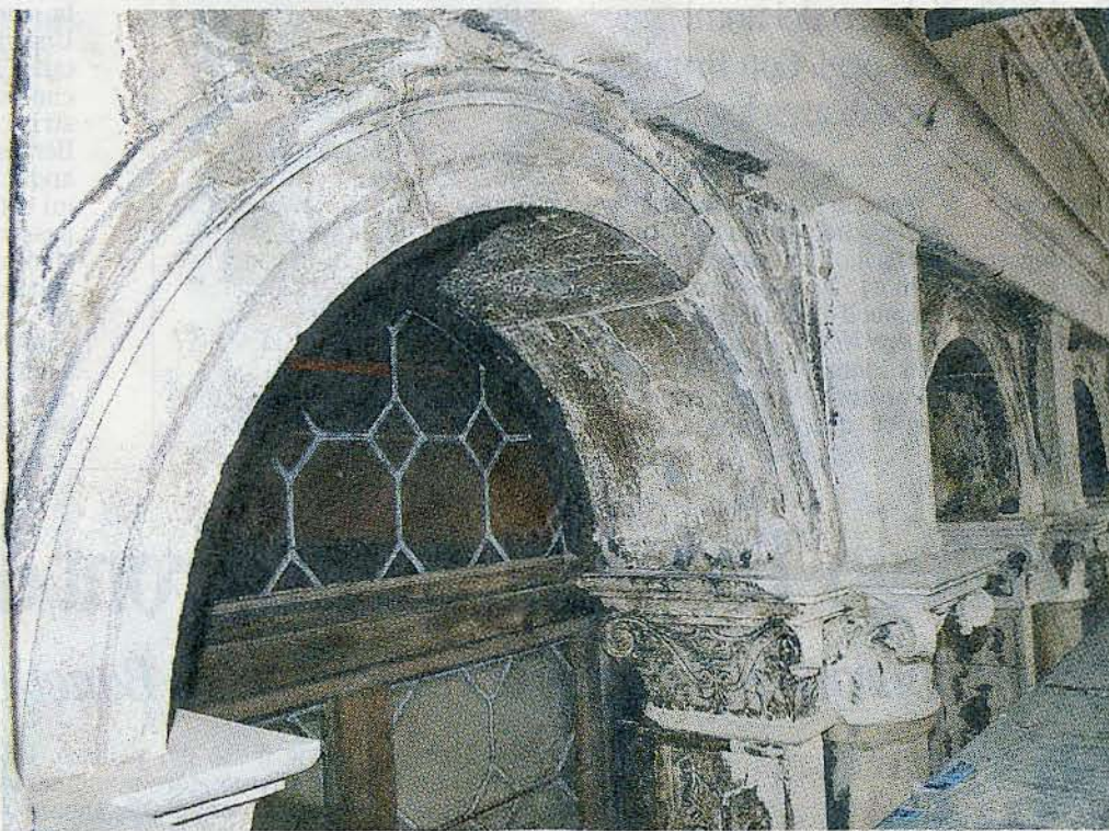
Una parte del palazzo dove è in atto un intervento di recupero e di pulizia che si concluderà a fine 2011
